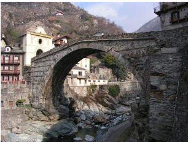
Römerbrücke in Pont Saint Martin
